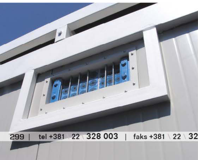
▼ uvednici za antenske kablove i elektroinstalacije (Roxtec)
