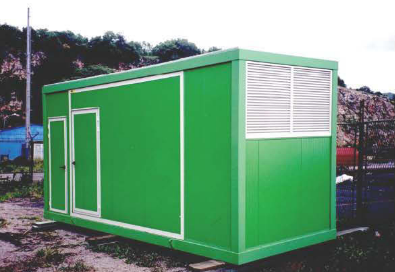
▲ kontejner 4604 12 za smeštaj kompresora Atlas Copco u brodogradilištu Viktor Lenac
