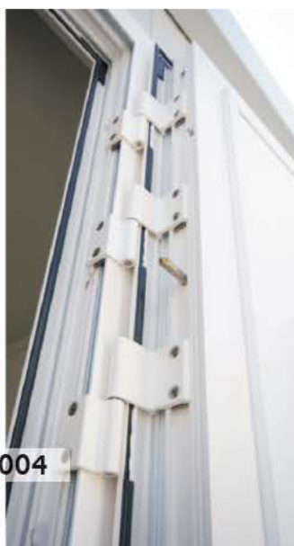
▼ detalj šarki vrata sa sistemom zaključavanja
